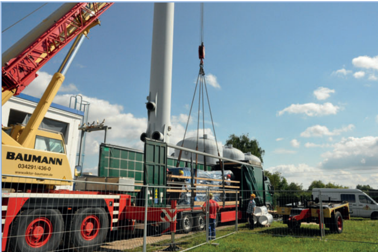
Montage des neuen Blockheizkraftwerkes im Wohngebiet Weißenfels-West
