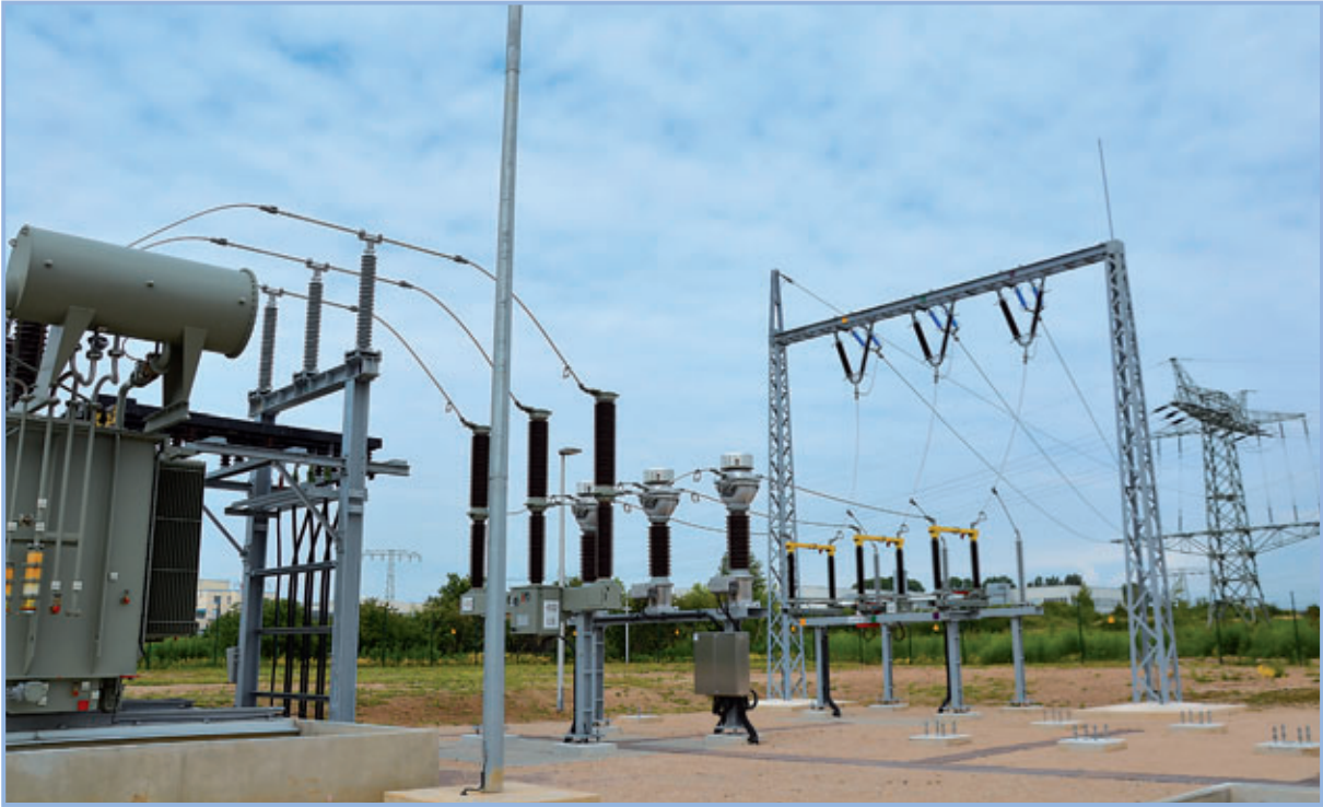
Neubau Umspannwerk Nord in Weißenfels
