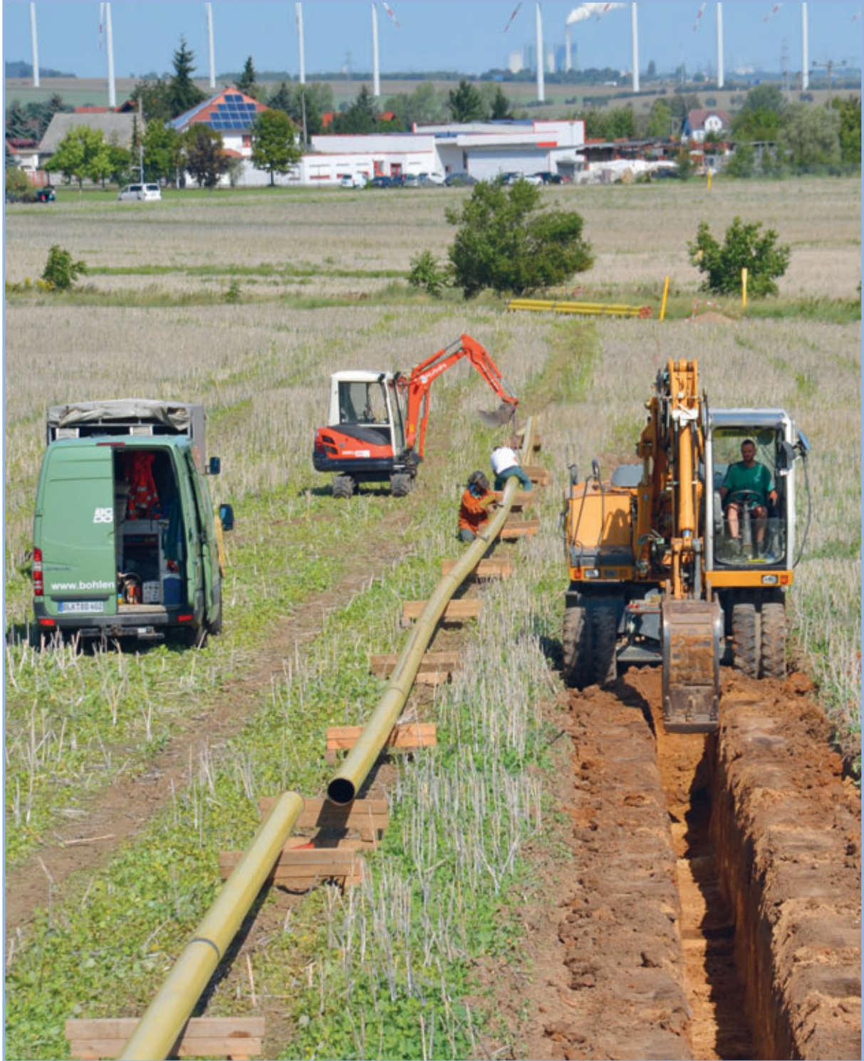
Sanierung einer Gashochdruckleitung an der B91 in Weißenfels
