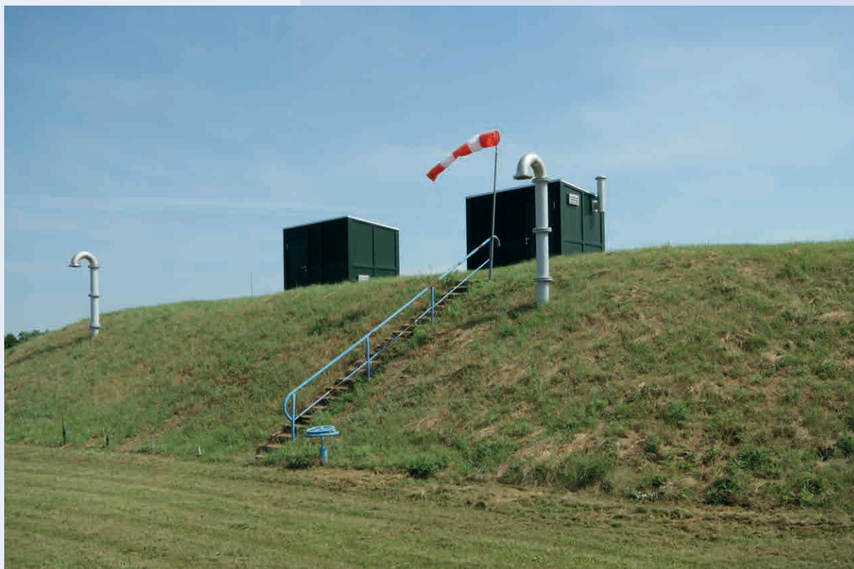
Reinwasserbehälter Wasserwerk Leißling
