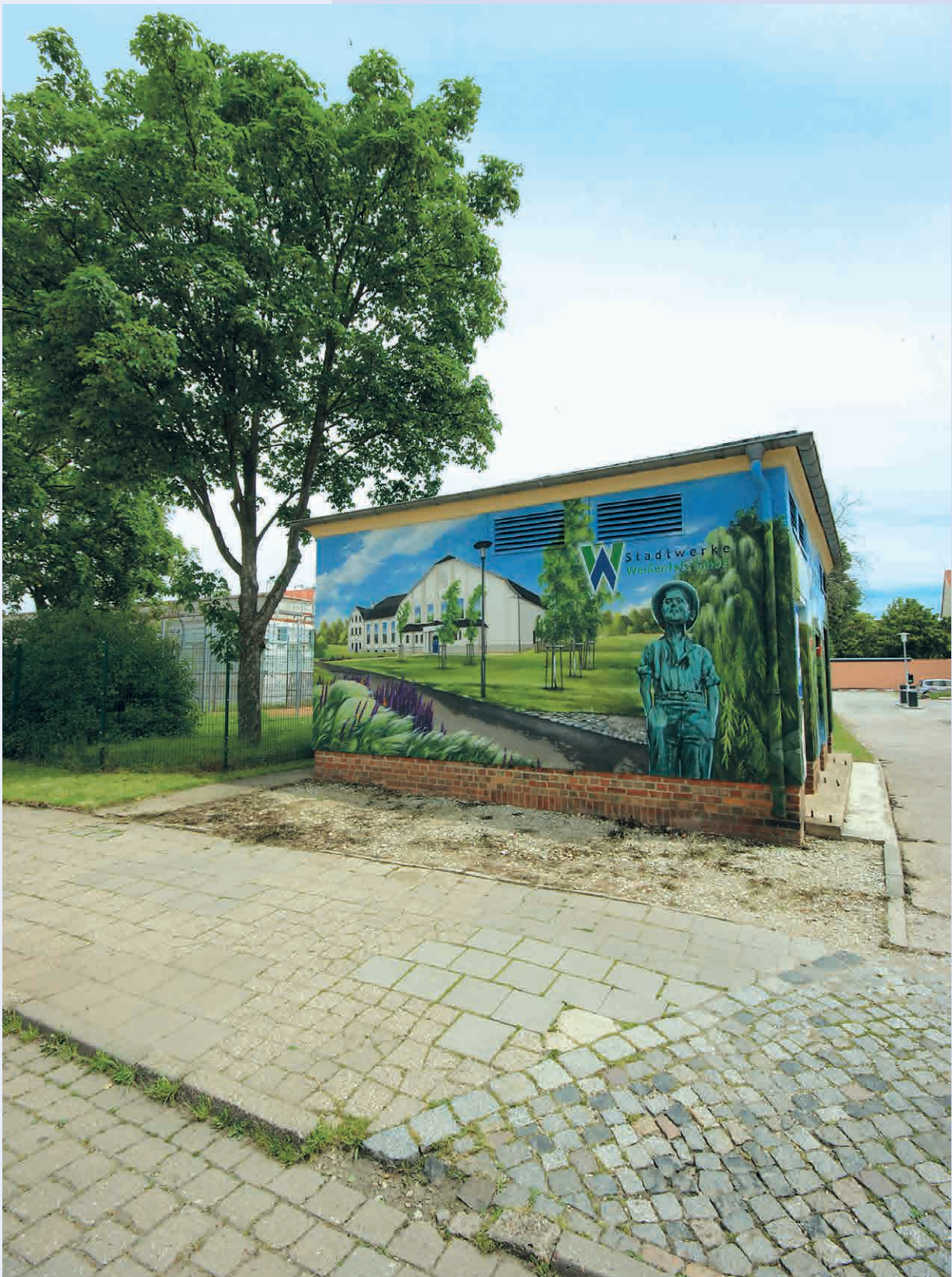
Transformatorhaus Uhlandstraße in Weißenfels
