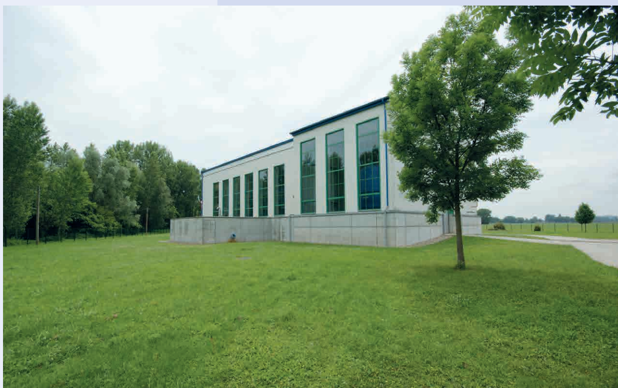
Wasserwerk Markwerbener Wiese in Weißenfels
