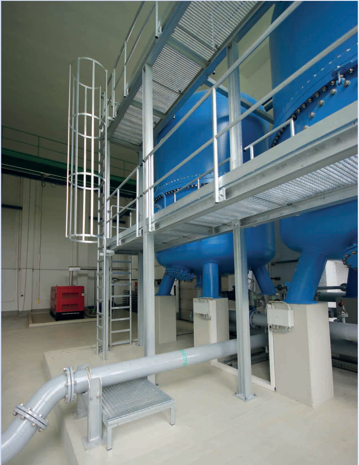
Wasserwerk Markwerbener Wiese in Weißenfels
