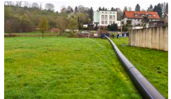
Die Rohrleitung wird vor dem Einzug zusammengefügt und „am Stück“ in das Leerrohr eingezogen.
