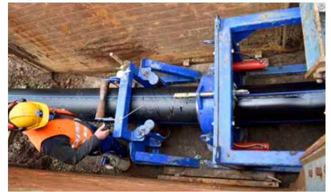
Einzug der neuen Transportleitung: Der Durchmesser der neuen Leitung wird durch Reduktion an den des Leerrohres angepasst.
