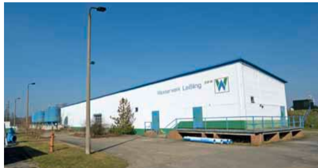
Zuverlässiger Wasserspender: Das Wasserwerk Leißling der Stadtwerke Weißenfels.
