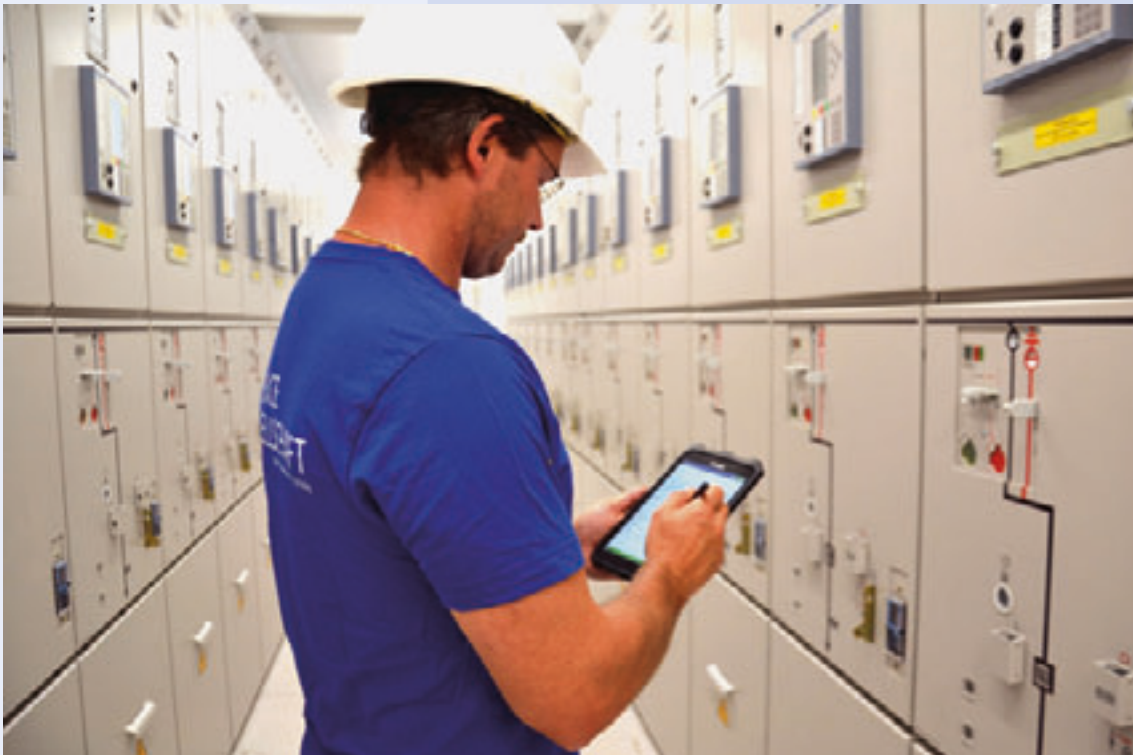
Arbeiten an den Versorgungsanlagen.
