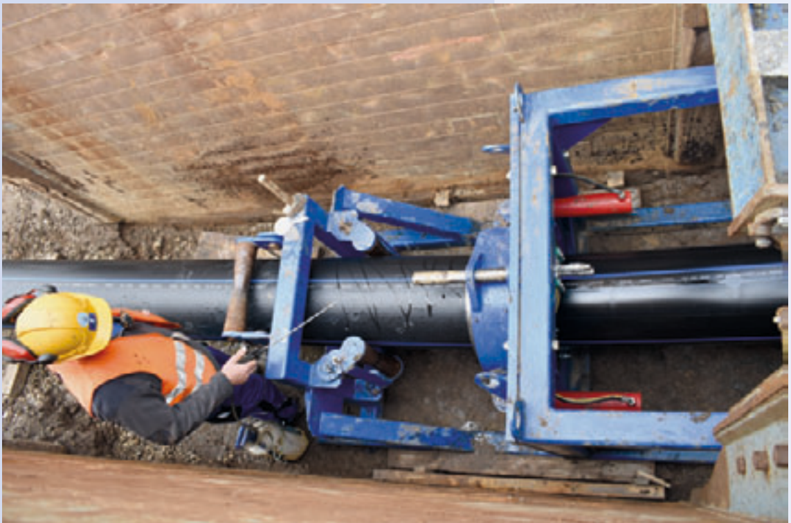
Durchörterung einer Trinkwassertransportleitung durch die Markworbener Straße in Weißenfels.
